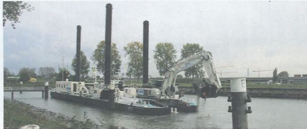
Backhoe dredger GD VI in actie tijdens de geslaagde praktijktest. Foto: Teus Vlot Dredging.
