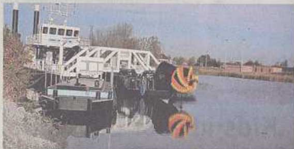
Het nieuwe baggerschip werd ter plaatse gemonteerd. Foto JVK.
