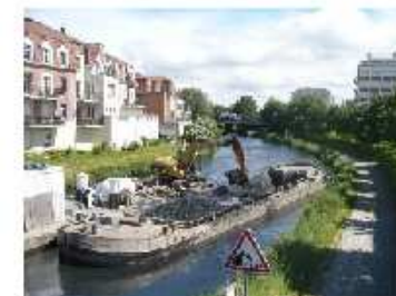
Dragages en cours à côté de la passerelle du Risban à Marcq-en-Barœul
