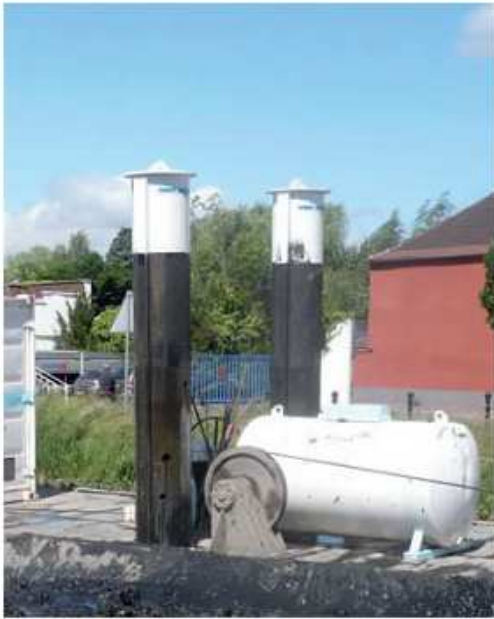
Les pieux hydrauliques en position haute pour le déplacement du ponton; ils sont ensuite abaissés pour le fixer dans le lit.
