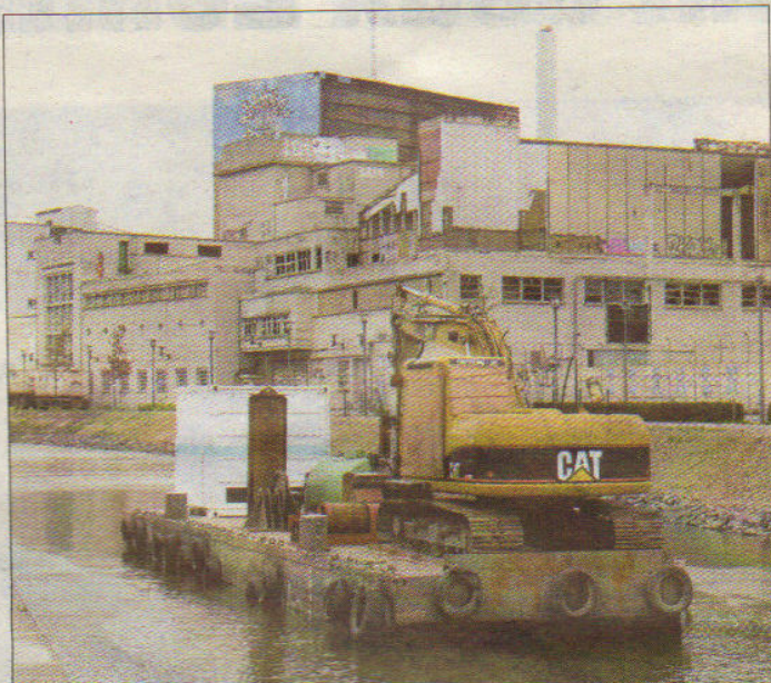
Le canal, ancienne artère irriguant les usines, doit être réhabilité. Les travaux sont perturbés par un niveau d'eau trop bas.
