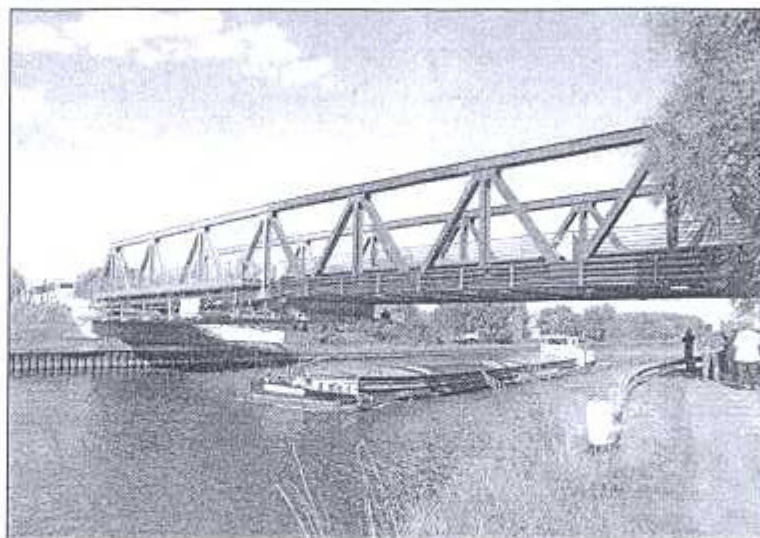
1. Een binnenschip passeert onder de opgehoogde brug van Neuville. De schipper aarzde niet om zijn opinie over het 'spaarzame' opvijzelen van de brug te laten horen. Foto T. Fasov
