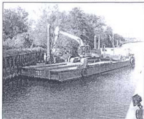
2. Ghent Dredging aan het werk bij het verbeteren van de oeverbescherming stroomopwaarts van de sluis van Fresnes. Foto T. Fasov
