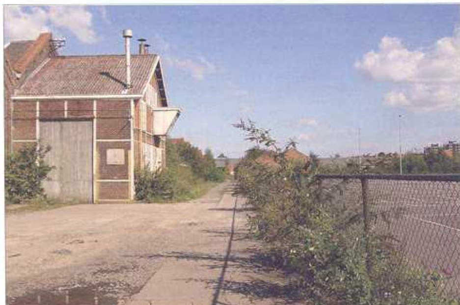
Na de bouwvakantie worden een aantal gebouwen op de Centrale Werkplaatsen gesloopt. Alleen de hallen 4, 5 en 9 zijn beschermd.
