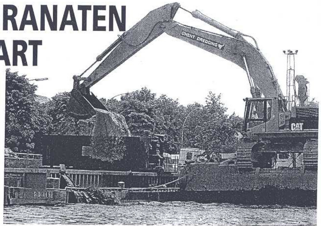
Een kraan van Ghent Dredging in actie bij het uitbaggeren van de Brugse Ringvaart. Foto Proot
