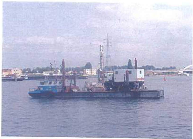
Geotechniek sondeert van op een spudponton
